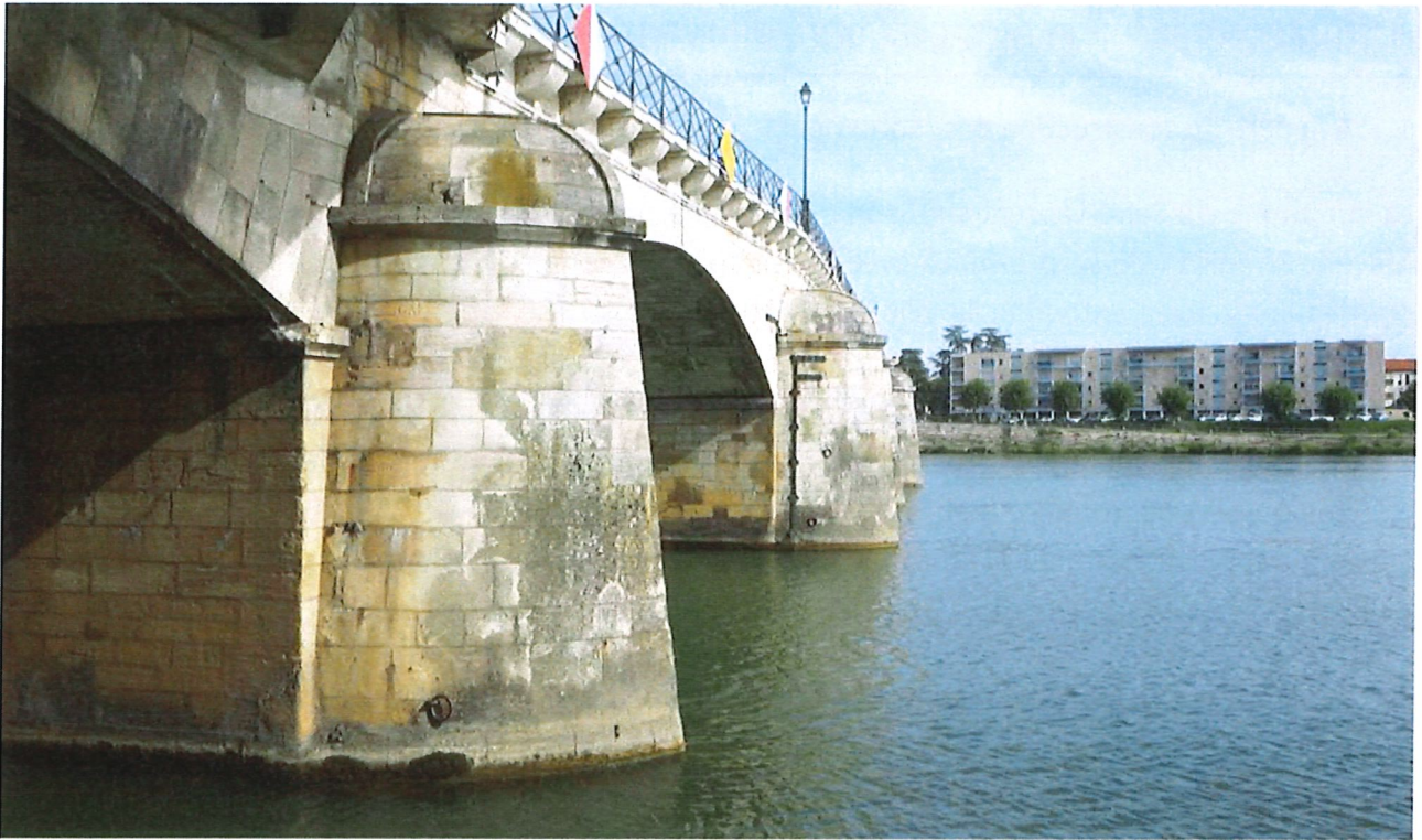
Photographie de la structure actuelle des voûtes qui composent le pont de Saint-Laurent (prise depuis la rive mâconnaise). Source : UDAP01, 2023.
