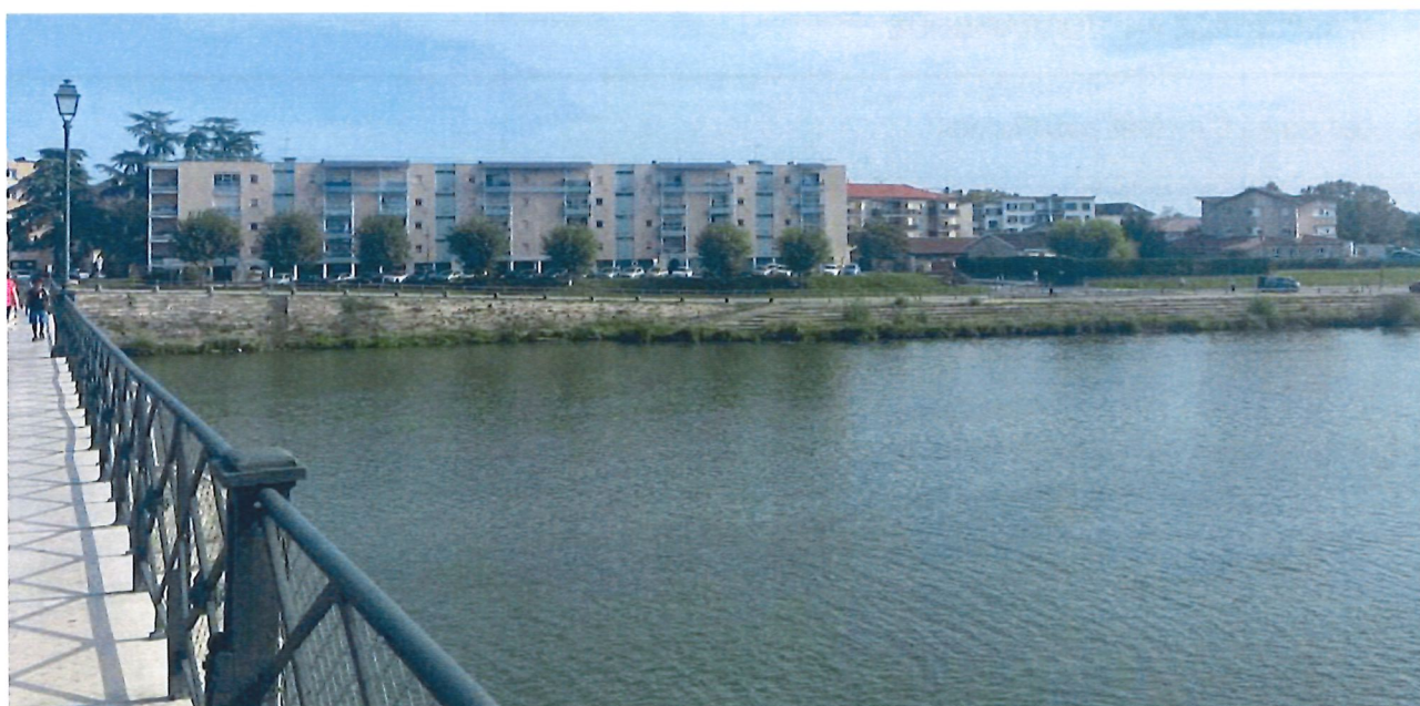
Vue depuis le pont sur la commune de Saint-Laurent, route du pont vert. Source : UDAP01, 2025.
